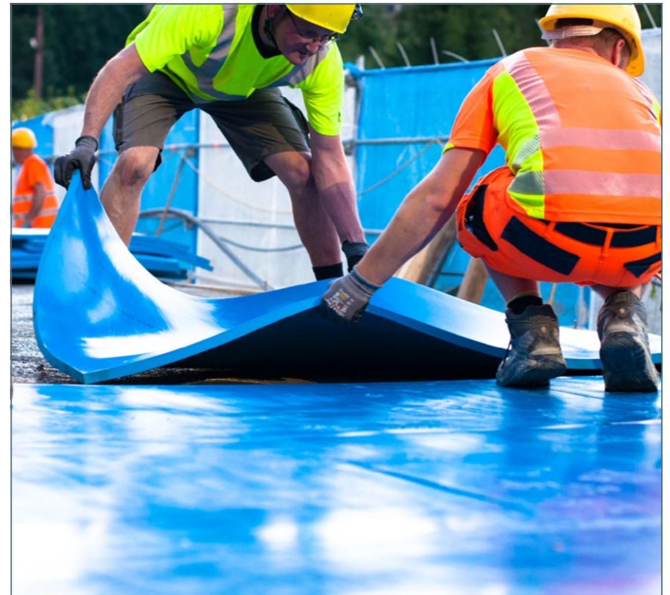
Einbausituation elastische Lagerung im Gleisbett
