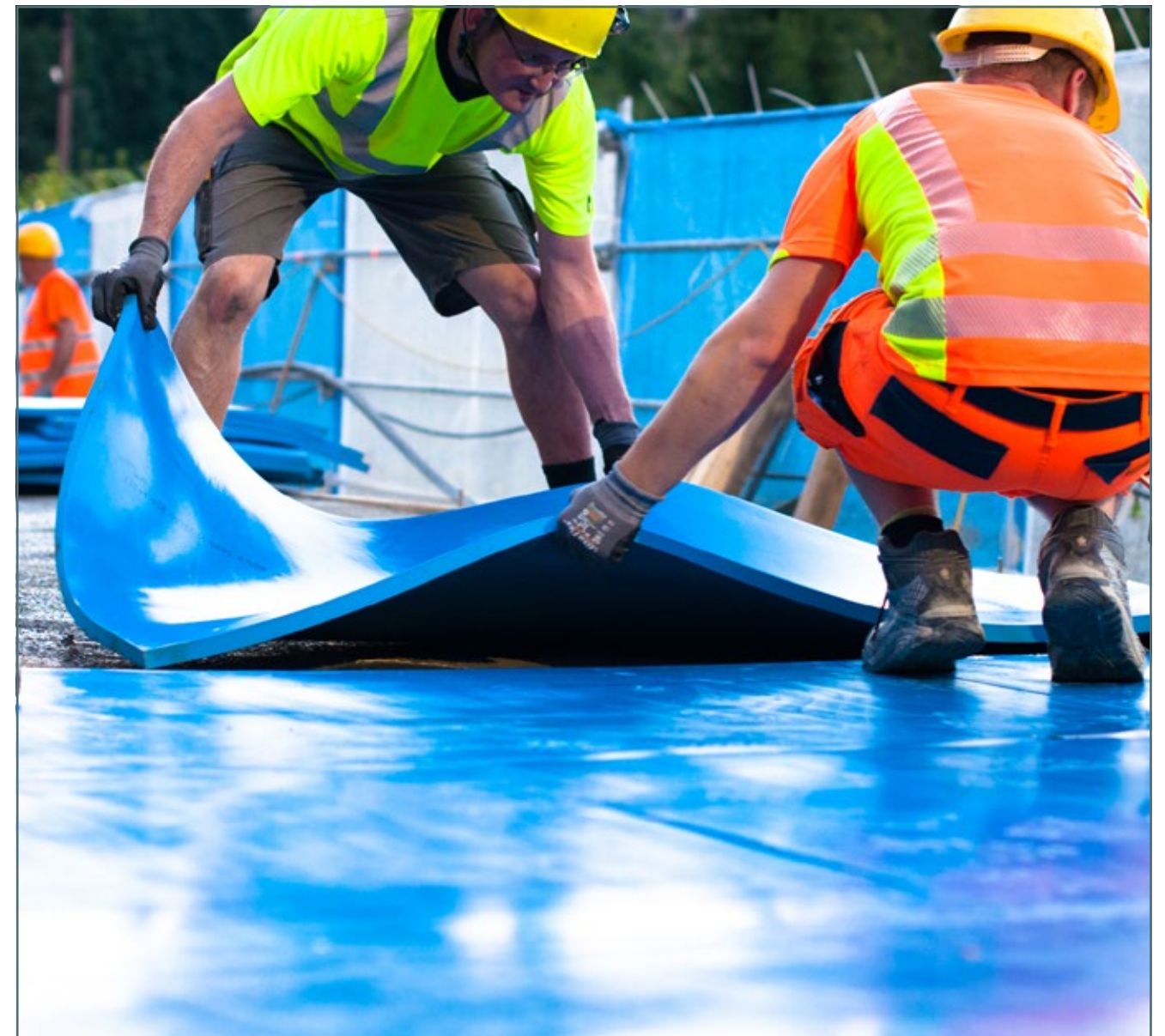
Einbausituation elastische Lagerung im Gleisbett
