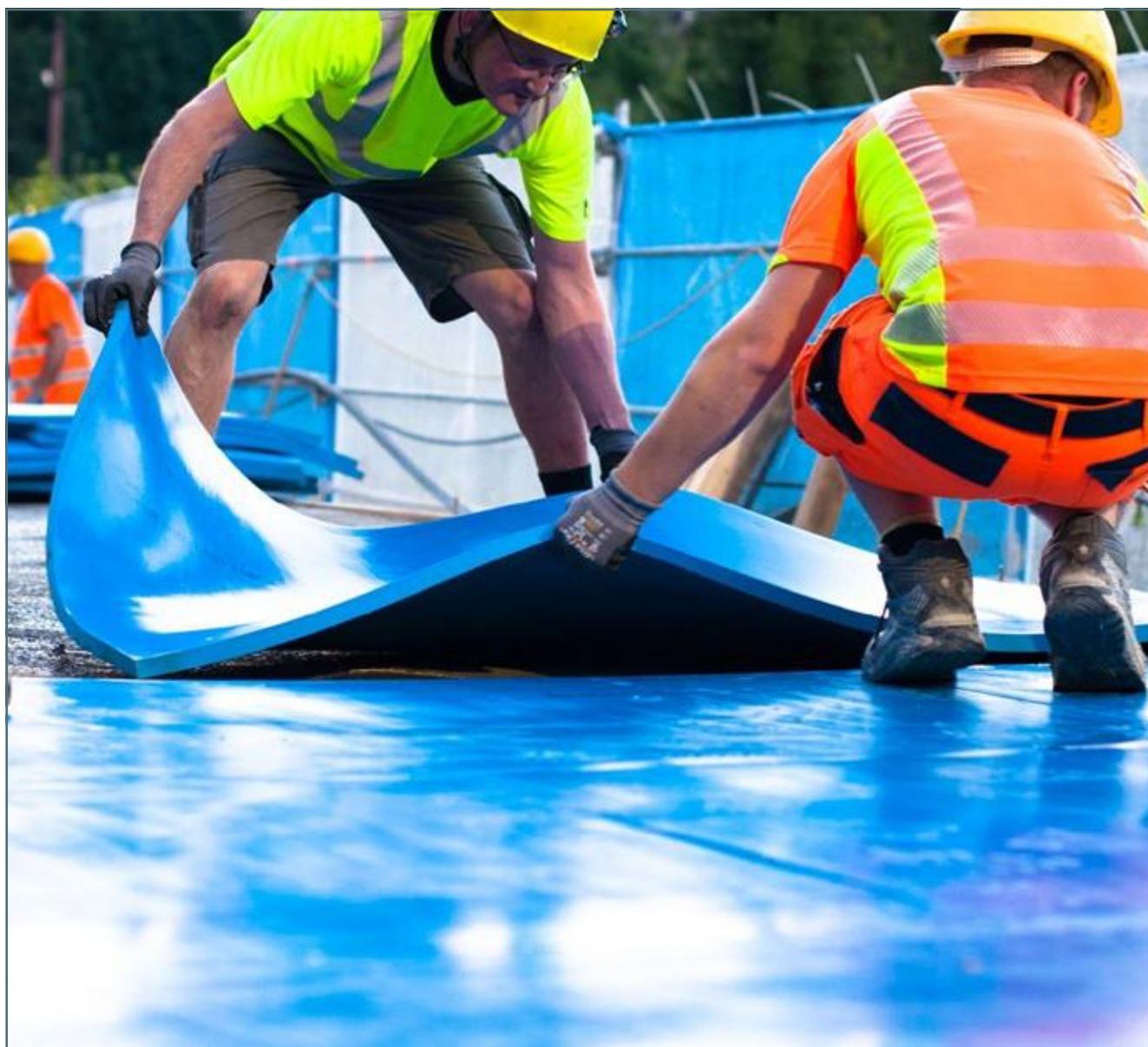
道床上弹性支座的安装
